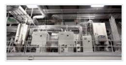
Wenn der Bedarf seitens der Spritzgießmaschinen abnimmt, werden die Trockner automatisch deaktiviert, um Energieverschwendung zu vermeiden. (Bildquelle: Pinyan) @
